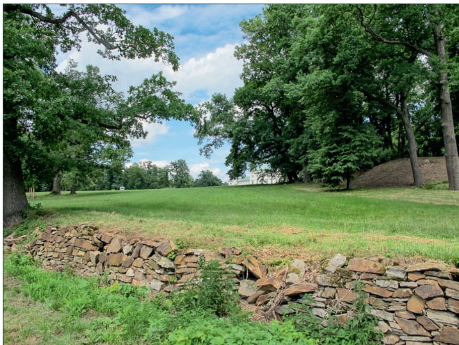
Příkop ha-ha odděluje obytnou část zámeckého parku Kačina od pastviny (KPZ Žehušicko)
