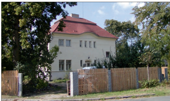
Čimelice, rodinná vilka čp. 113 v ulici k žel. nádraží, přelom 19. a 20. století. Souřadnice stanoviště N 49.46898, E 14.07317. Ing. arch. Václav Bouška 2010-06-18
