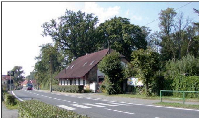
Čimelice, bývalá kovárna čp.101 u státní silnice Č. Budějovice-Praha, 1. pol. 19. století. Ing. arch. Václav Bouška 2010-06-18
