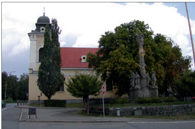
Čimelice, kostel Nejsvětější Trojice uprostřed východní části návsi; opravo v popředí morový sloup se sousoším Nejsvětější Trojice (2.pol.18.st). Václav Bouška, Ing. arch., 2010-06-18
